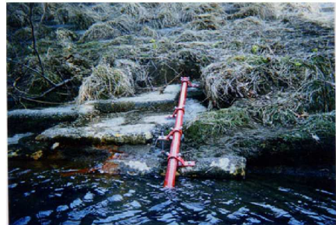
全自动远程遥测水位观测站
