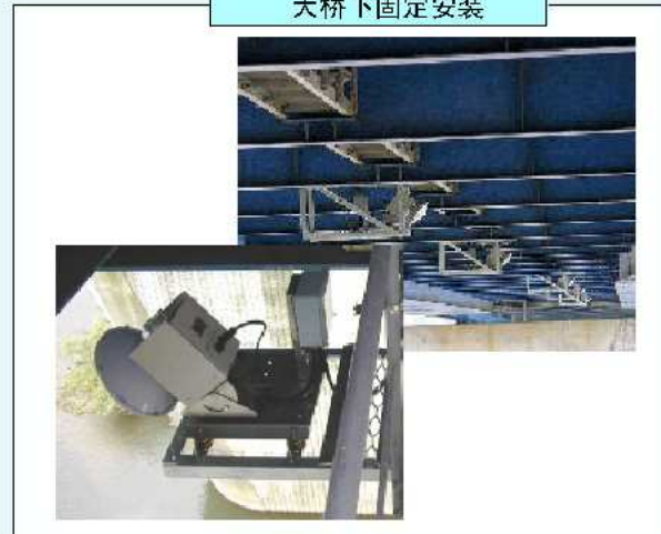
大桥下固定安装
