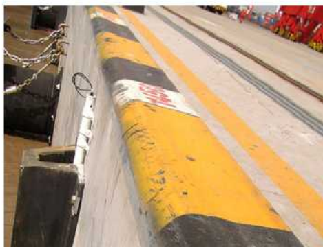
支架固定安装
