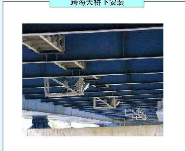
跨海大桥下安装
