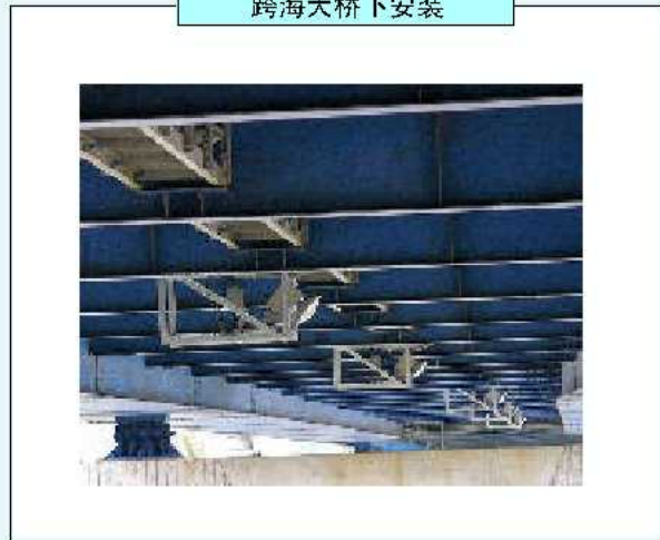
跨海大桥下安装
